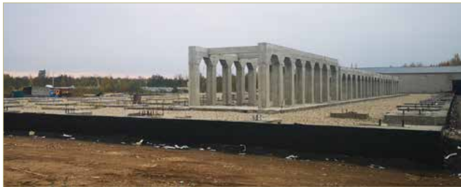
Сейчас идёт строительство площадки по производству бумаги и картона. Запуск запланирован на 2021 год.
