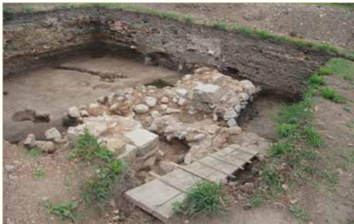
**Кладка с использованием плинфы и каменных обработанных блоков восходит к строительной технике Древнего Рима.**
