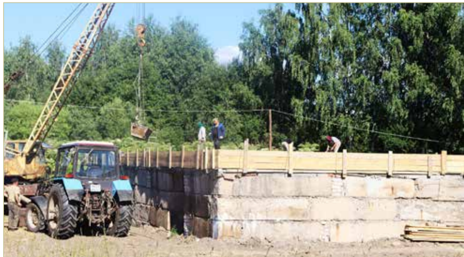
Иван Гелетей строит дом для работников КФХ.
