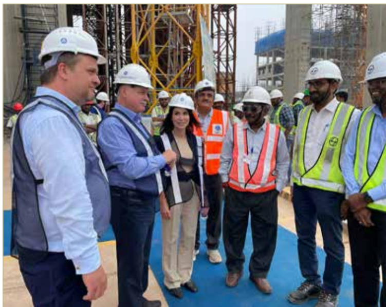
На строительной площадке атомной электростанции Куданкулам.
