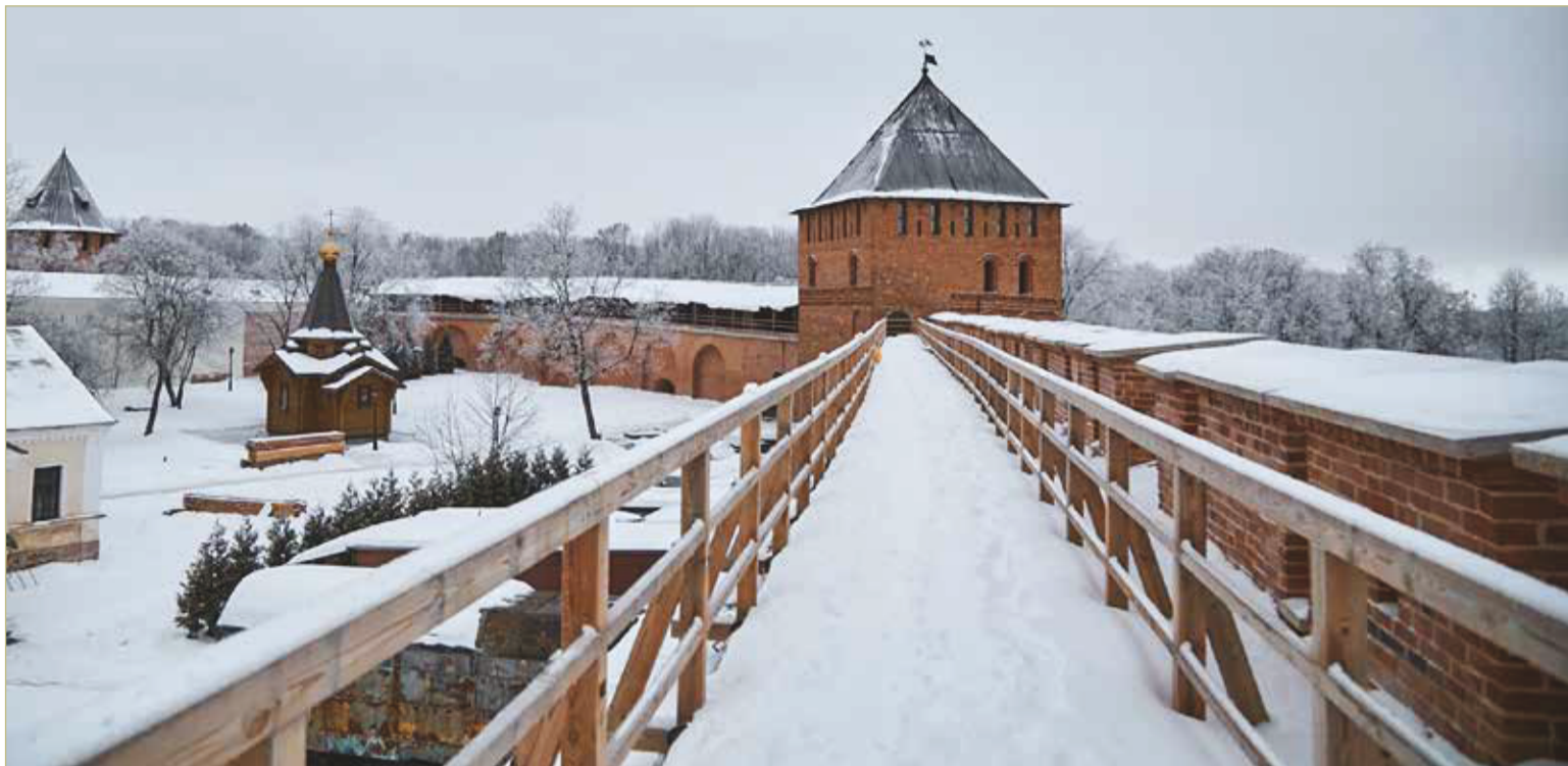
Реставраторы привели в порядок покрытие на 800-метровом участке боевого хода.
