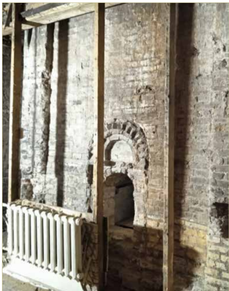
На открытой стене сохранился первоначальный декор — без штукатурки и не пострадавший от погодных условий.
