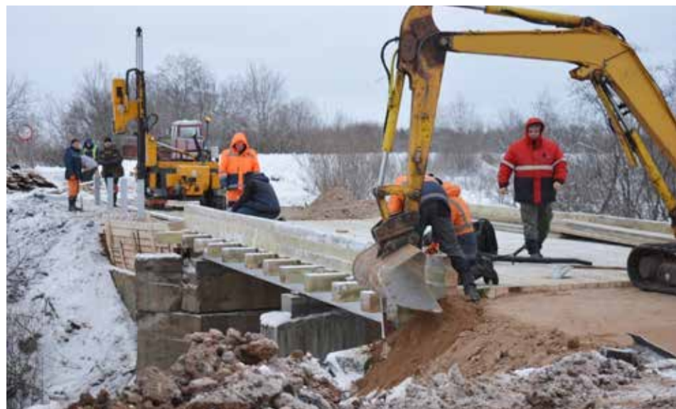
Одно из главных направлений работы дорожников — ремонт мостов и путепроводов. На фото: ремонт моста через реку Лужонка в Демянском районе. Фото предоставлено пресс-службой «Новгородавтодора»
