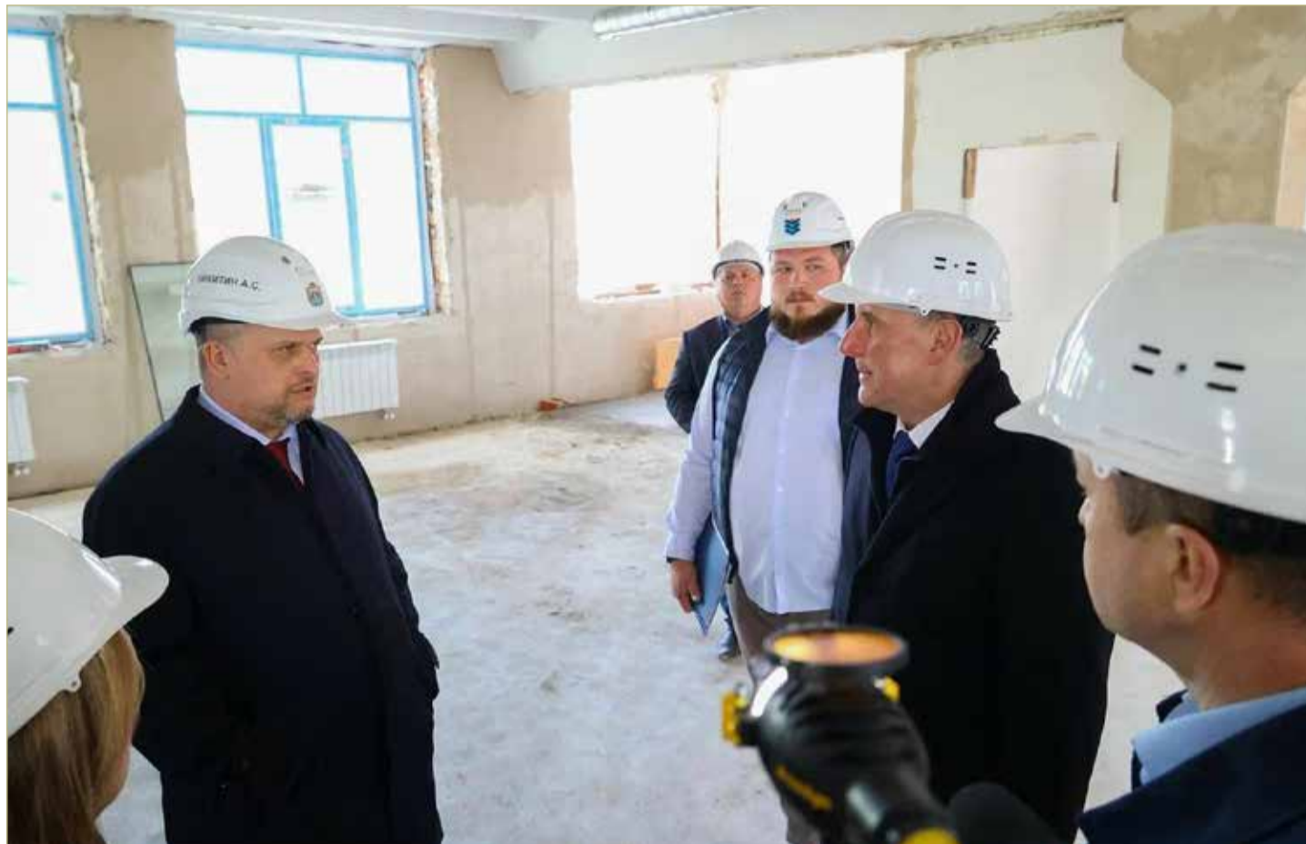
Андрей Никитин осмотрел ход ремонтных работ.
