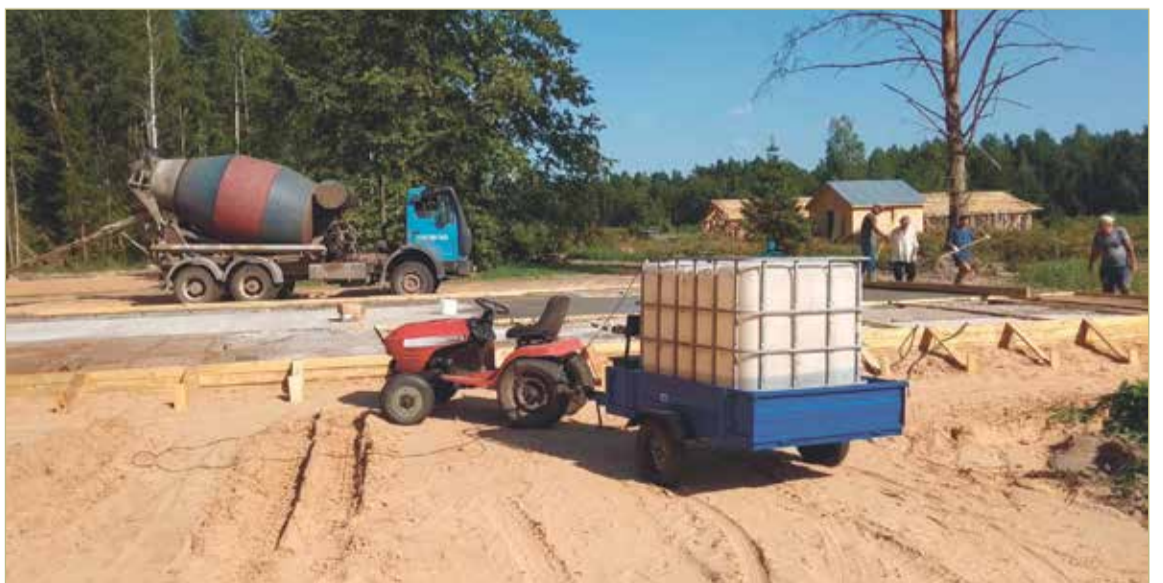
Начало работ по проекту «Агротуризм». Здесь будет построена новая ферма по старинным образцам.
