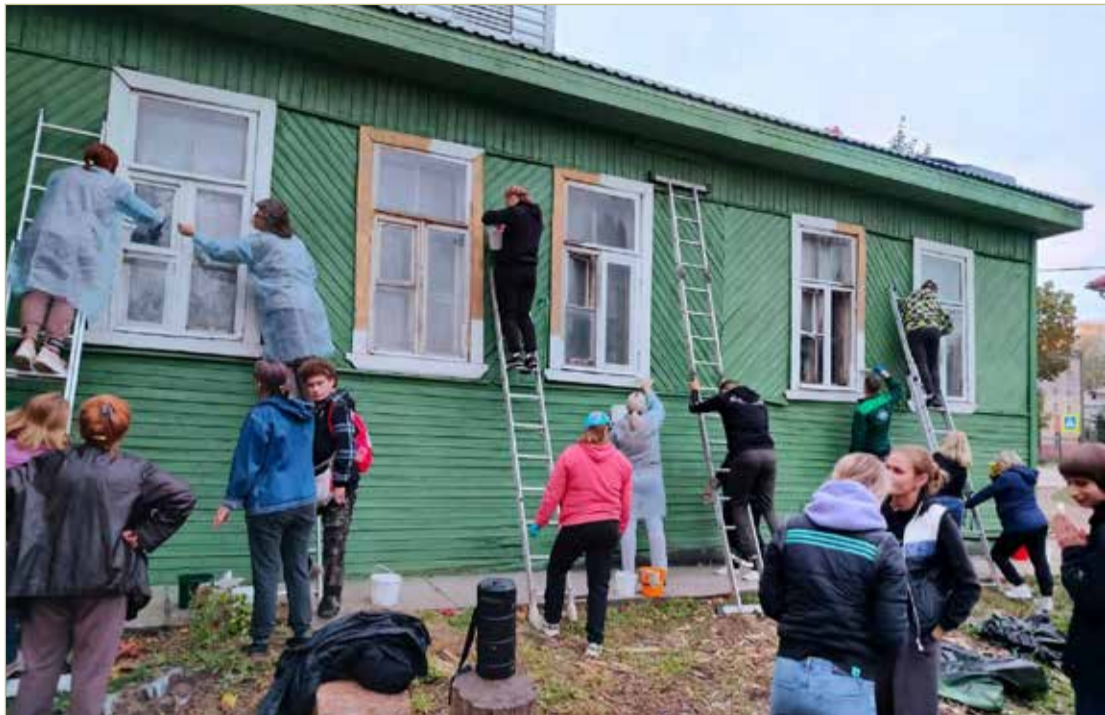
После всех необходимых согласований жизнь на объекте закипела. Фото из архива Елены ПОВАРОВОЙ
