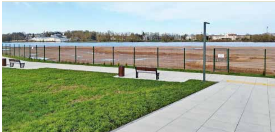
На волховском берегу укладывают тонны песка, чтобы поднять его уровень и исключить подтопление.
