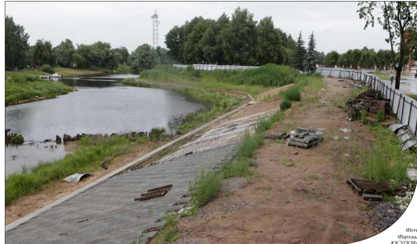
Согласно новому проекту, откосы берега будут выложены булыжником
